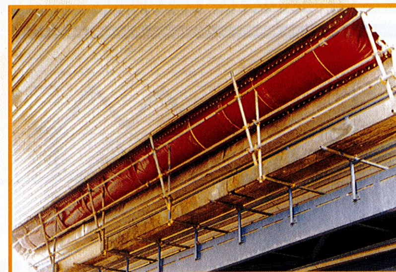
Mehrlagenkompensator mit Vorisolierung in einer Denox-Anlage für Kohlekraftwerk
